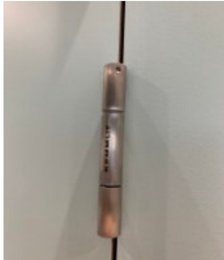
Paumelle indégondable à 3 rouleaux en inox
