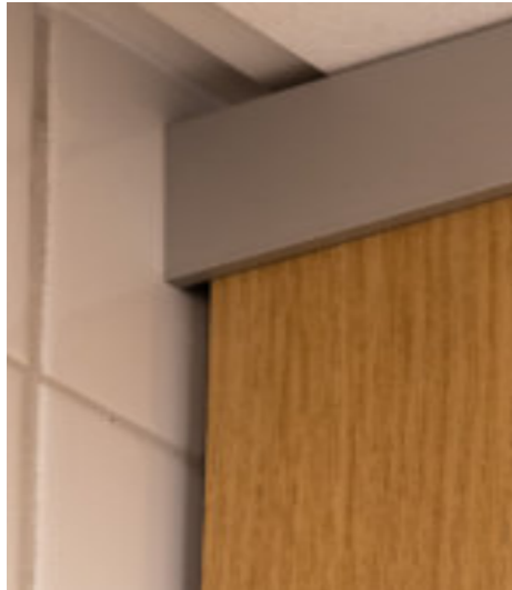
Fixation murale par joints-creux
